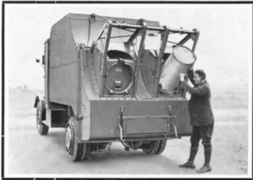
Faun-Rolltrommel-Müllwagen mit staubfreier Einschüttung
