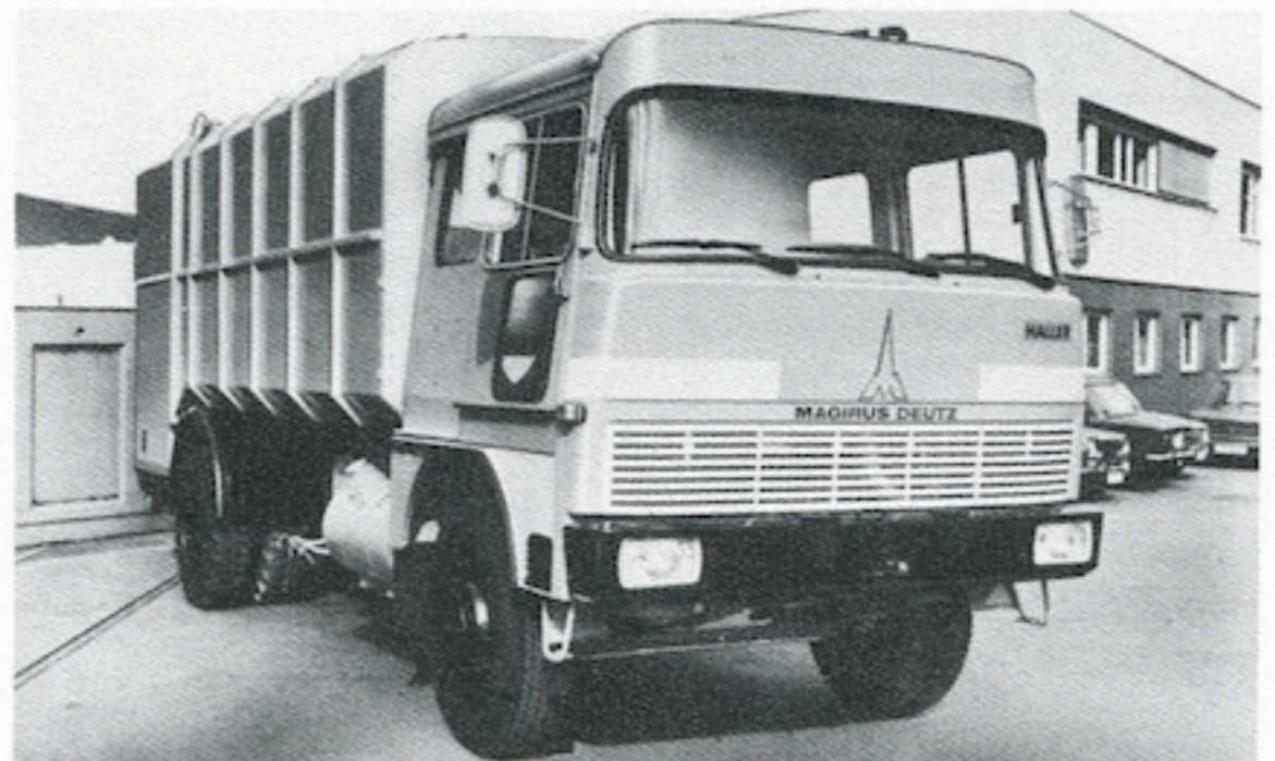
Haller-Kompaktmüllwagen-Aufbau Typ M 15 S, mit einem Behälter-Volumen von 15 m 3 , für alle Müllarten mit Großraumfahrerhaus
