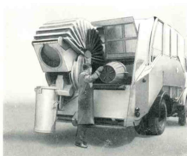
Benne REY équipée d'un appareillage mixte permettant à la fois la vidange hermétique et mécanique de poubelles standardisées et la vidange de poubelles traditionnelles.
